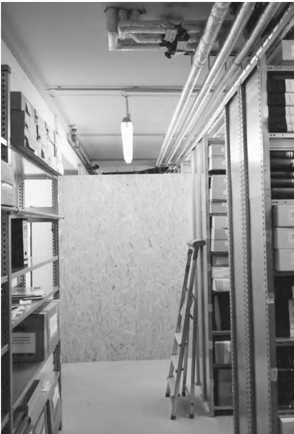
Trennwand aus OSB-Platte, Foto: Michael Habersack
