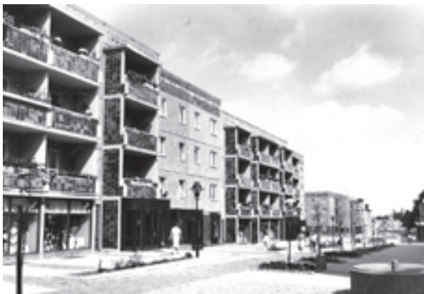
Neubau der Straße der Republik / Friedrichstr. mit Plattenbauten, 1983/84.
