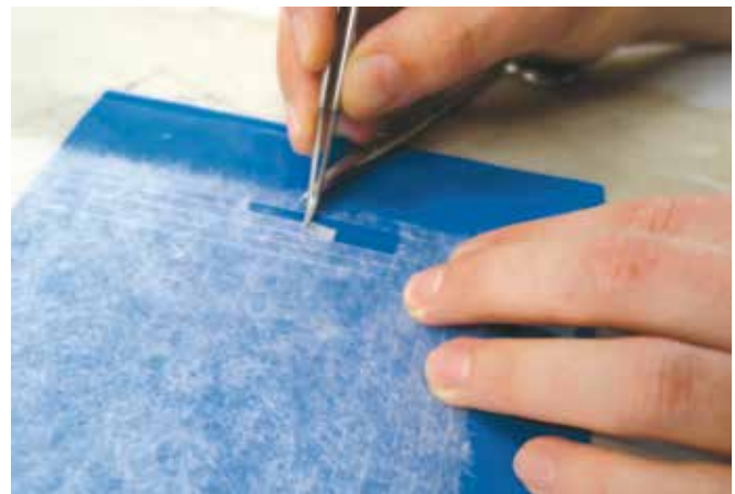
Vorbereitetes Japanpapier zur Risssschließung
