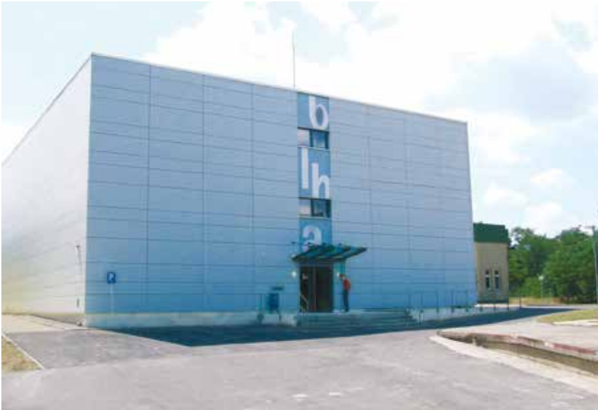
Der Neubau mit Magazin und Lesesaal in Bornim im Jahr 2006
